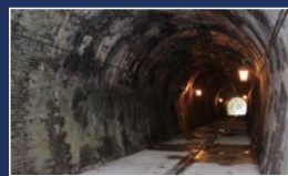
柳曲トンネル 煉瓦を用いて築いているのが特徴的
