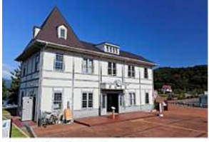
旧敦賀港駅舎-1(9MB).JPG
